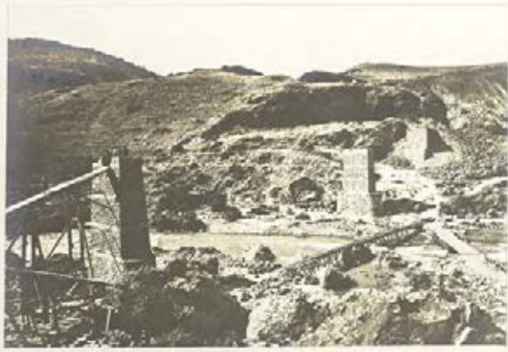
خط كبير عالينك حيفا شعبه سي انشآت و اعمالانندن يوز برنجي كيلومتره داخلنده اوج كوزلى يوز اون متره لك تيمور كوبرينك كار كير قسمى انشآتى عملياتى
