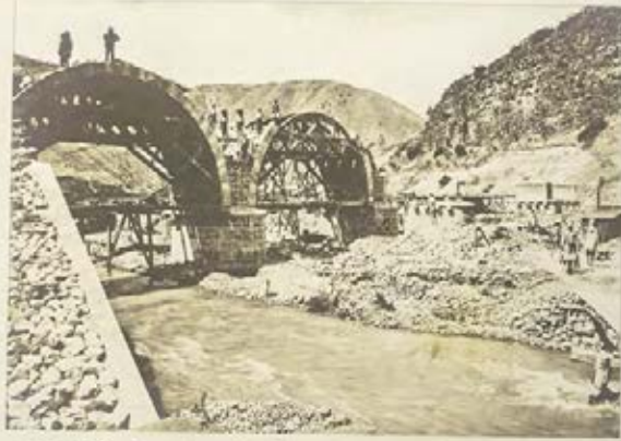
خط عالي حيفا شعبة سندده و يوز كيلومتره داخلنده اولوب ايكي بخارلي ماكنه ايله جالشديغي حالده بالكز تمل حفرياتى برسنه امتداد ايدن طقسان متره لك كوپرى.
