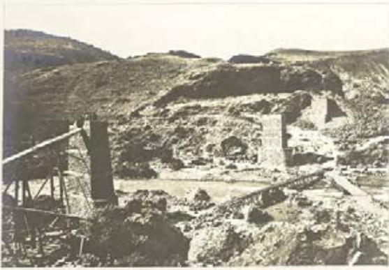
خط كبري عالينك حيفا شعبه سي انشآت و اعمالاتندن يوز برنجي كيلومتره داخلنده اوج كوزلي يوز اون متره لك تيمور كوبرينك كار كير قسمي انشآتي عملياتي.
