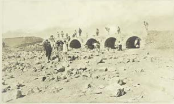
احاسن ميراث سنیه جناب جهانبانندن حمیدیه حجاز تیموریولنده و شامدن اعتباراً درتیوز طقسان بشنجی کیلومتره داخلنده و معلی ایلروسنده واقع التی کوزلی کارگیر کوپرنیک انشاآت.
