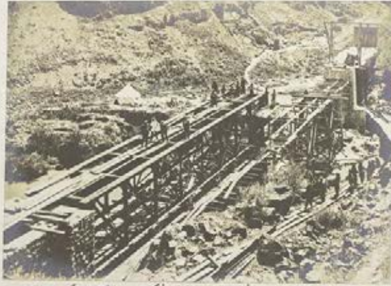
خط عالي حيفا شعبي وسننه وحيفا مبدأ اعتباريله طقسان دردنجي كيلومتره داخلنده اوج كوزلي يوز اون تيمور كوبرينك صورت تركيبي.
