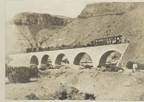
جسر القناطر الخمس وواجهته الحجرية بطول 60 متراً والواقع على فرع حيفا من الخط العظيم، من الهياكل والأشغال عند الكيلومتر الـ 110 بعيداً عن حيفا.
