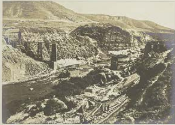
خط عالي حيفا شعبه سنده وحيفا مبدأ اعتباريله طقسان اوچنجي كيلومتره داخلنده اوج كوزلي يوز اون متره لك يارموق تيمور كوپريسي انشآآتي.
