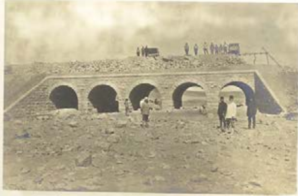
مؤسسات محاسن غايات سنية جناب خلافتهناهيدين اولان حميديه حجاز تيمور يولى معان ايلروسي انشآتندن درت يوز طقسان اوچنجي كيلومتره ده بش كوزلى كار كبير كوبرى.
